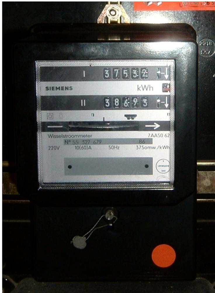
**Abbildung 2.13:** Mehrtarif-Stromzähler, Messung nach dem Ferrarisprinzip<sup>14</sup>
