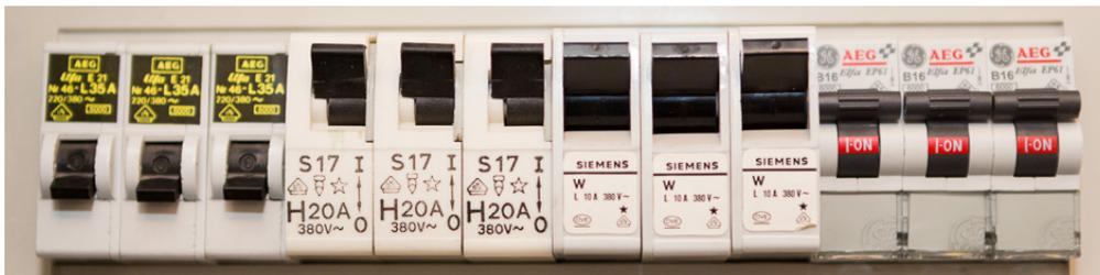
Abbildung 3.2: Leitungsschutzschalter
