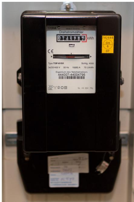
**Abbildung 3.4:** einfacher Drehstromzähler
